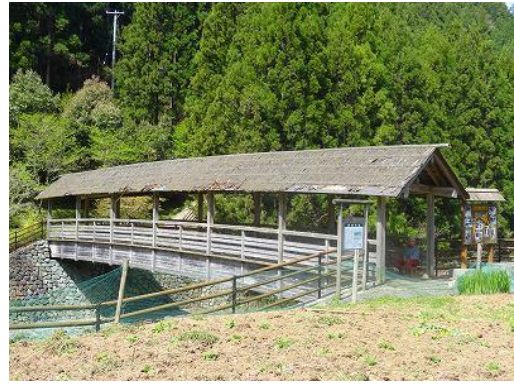
1-3. 河辺川には多くの屋根付き橋が この橋はP C桁の上に屋根が
