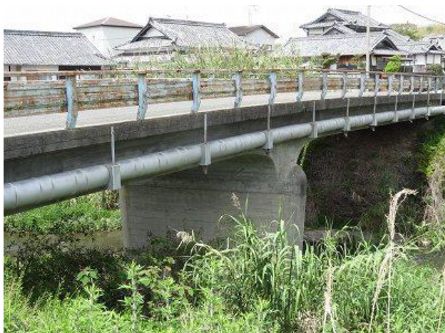
18. 桁と橋脚が一体となったラーメン構造の橋は珍しい
