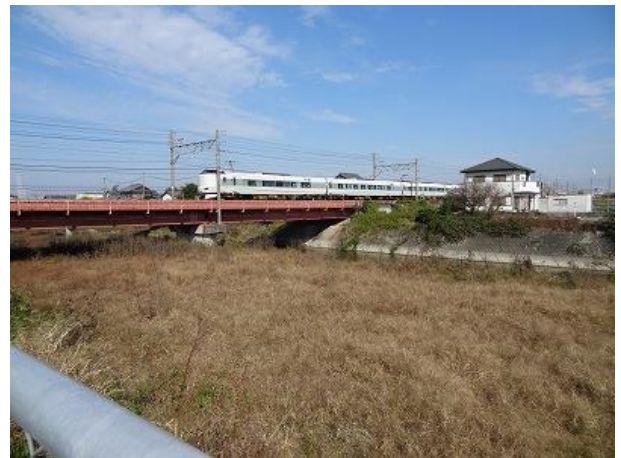
06.特急「くろしお」が樫井川橋梁を通過
