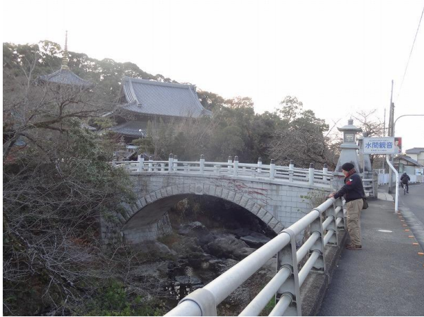
「水間寺」の入口は立派なアーチ橋
