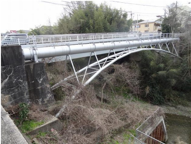
15.パイプトラスの水道橋は立派だな
