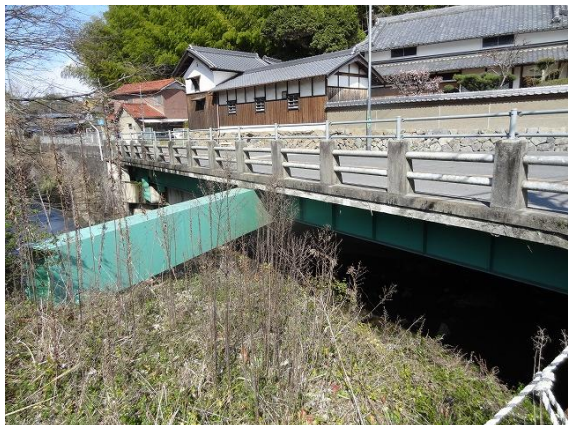
17.斜角20度の「船渡橋」は大股ぎ構造
