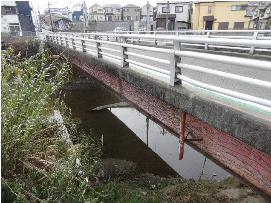
32.橋の点検しているのかなー
