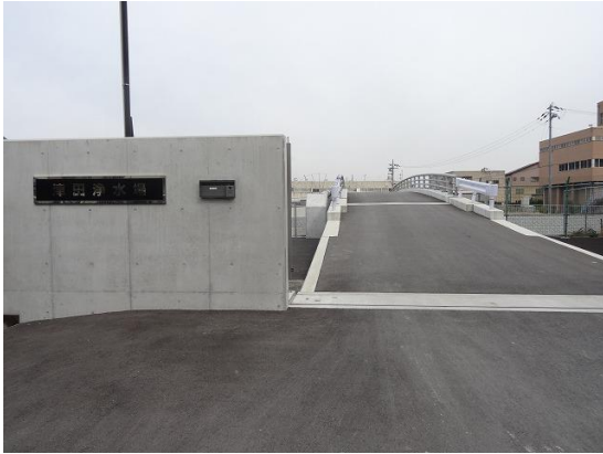
28.貝塚市津田浄水場への私道橋
