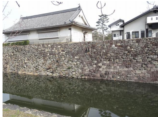
12.城壁は積み方の異なる石積みが混在している
