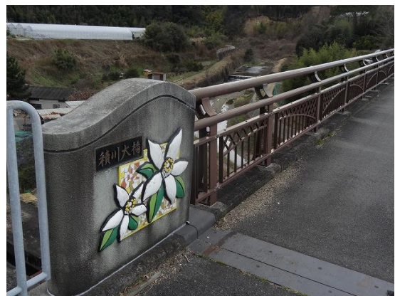
14. 国道 170 号の積川大橋の親柱には花が咲いている
