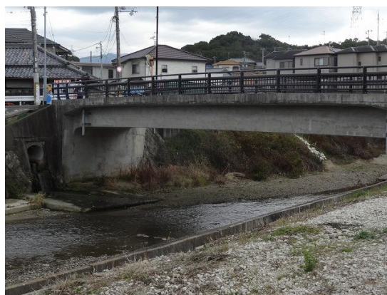
07.長径間のコンクリートラーメン橋 だな
