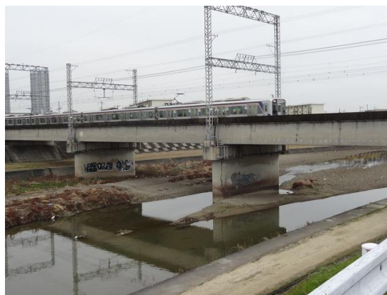
15.河口からは左岸側を上流に
