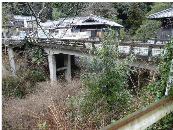
08.桁と橋脚が一体となったラーメン橋が
