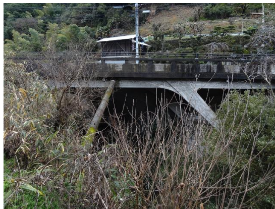
09.お次は方杖付きラーメン橋が現る
