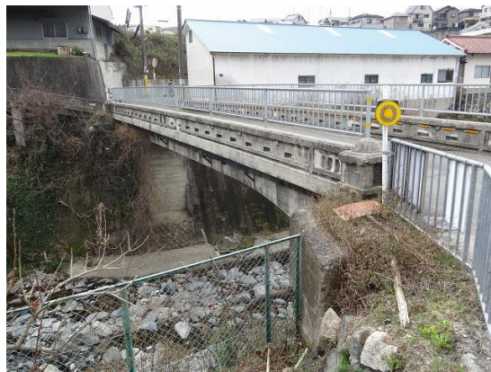
12.親柱の裏には工事概要が細かく記載されている
