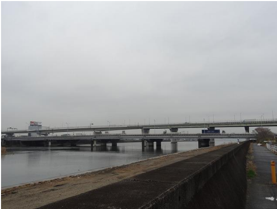
12.河口部を横切る阪神高速湾岸線と府道 29 号
