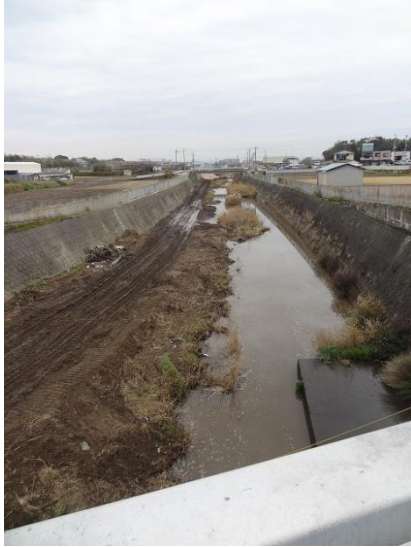
08.河川改良工事のための進入路が
