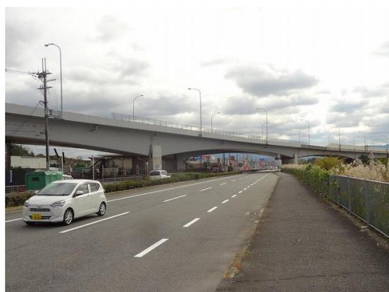
06.阪和道の橋は PC 変断面連続箱桁、懐かしい
