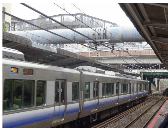
25. 「三国ヶ丘」駅のホームの上を太い水道管が横断
