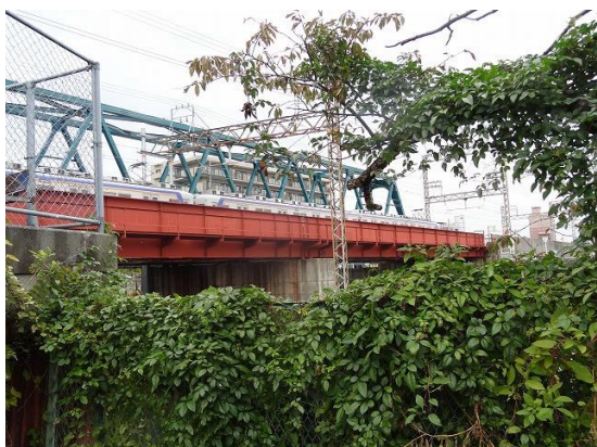
10.南海本線の複線橋の横に単線の未供用の橋が
