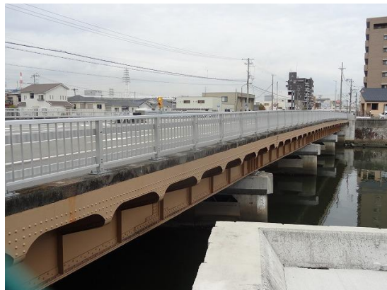
09.府道 204 号の「石津川橋」はなんと昭和 8 年完成の橋
