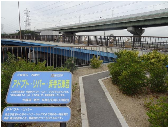
05.河口部に架かる阪神高速と府道 29号の橋
