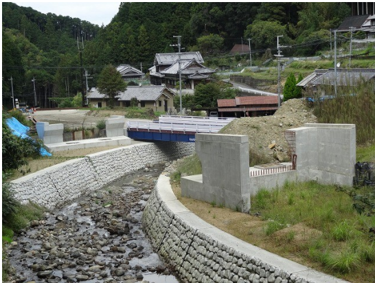
25. 県道改良の橋の工事が実施中
