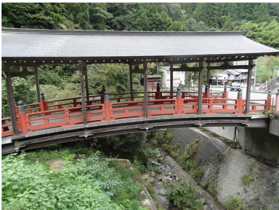
20.屋形橋の桁は鋼桁でした
