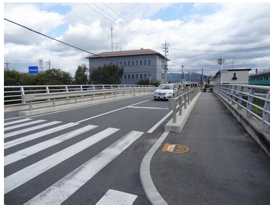
07.「興仁橋」の歩道と車道の間には防護柵が
