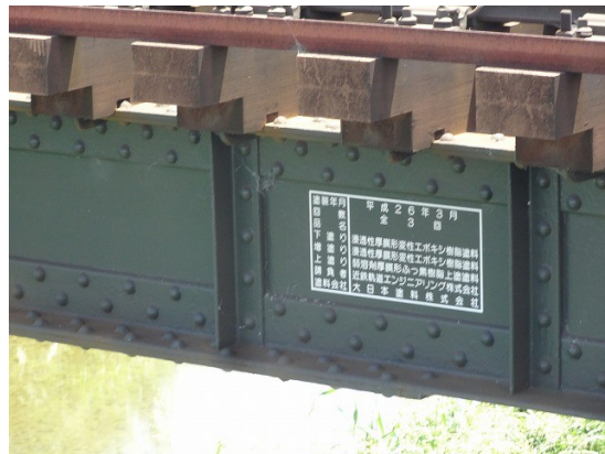
04.近鉄は鉄道橋にフッ素樹脂塗料を塗りだした
