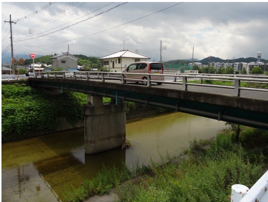
03.高下駄を履いた鋼桁だ
