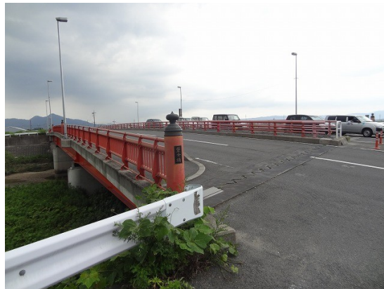
27.県道 105 号の「磐余橋」は「いわれ」と読む難読橋だ
