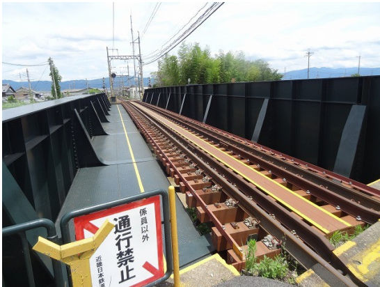
21.田原本線の橋には真っ新たな枕木が
