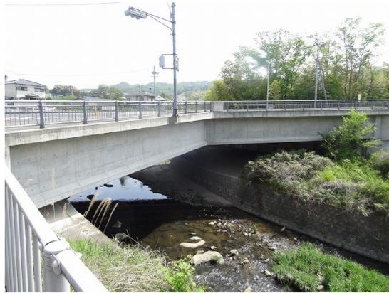
03. 拡幅部ではPC桁にPC桁を繋いでいる
