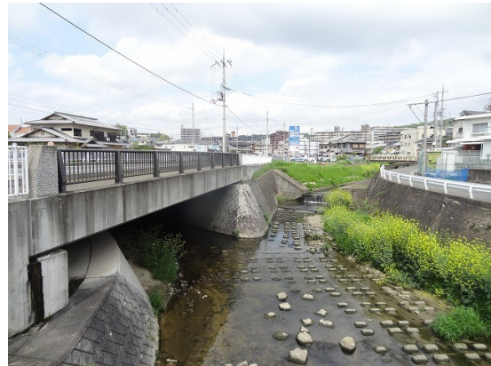
05.国道 168 号の橋際で北東からの支流を合わせる
