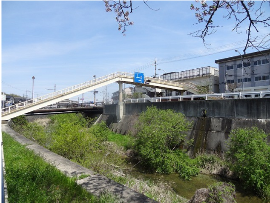
03.富雄北小学校前の歩道橋は瓜二つだ
