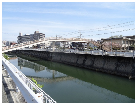
02.富雄中学校前の横断歩道橋は川と県道を一跨ぎ
