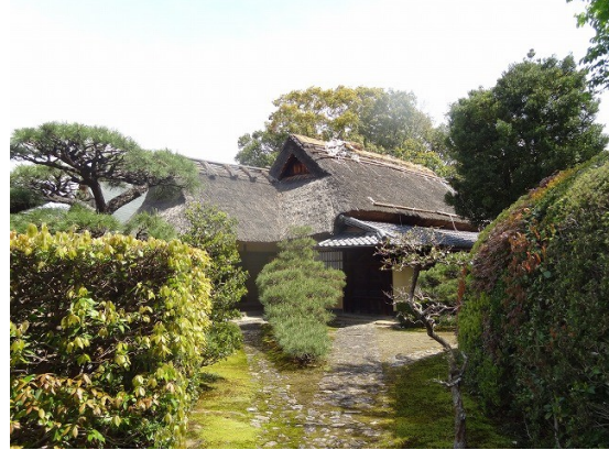
06.入母屋造りの屋根を修復中
