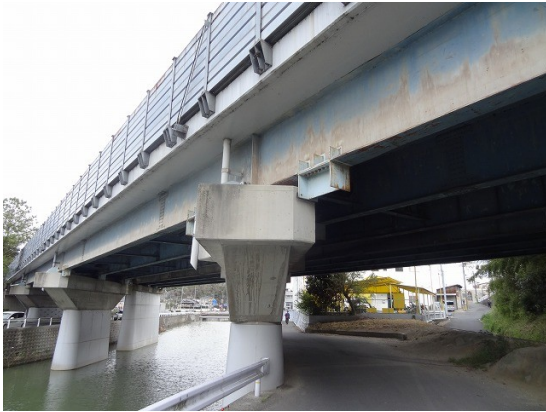
14. 阪奈道路の橋の状態は良くない
