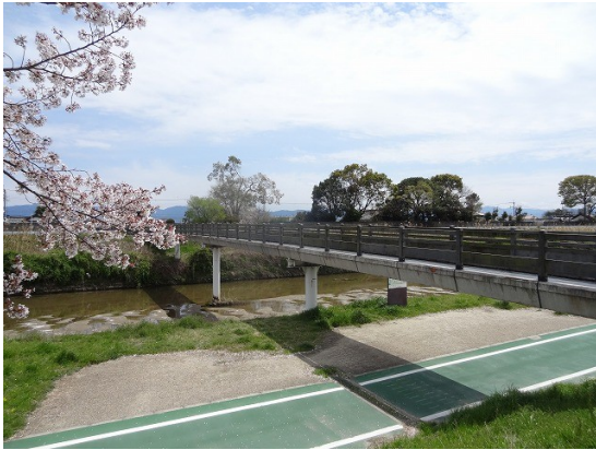
09.高欄が木製の歩道橋
