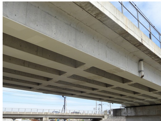
08.鋼桁にコンクリートを併用したハイブリッド桁だ
