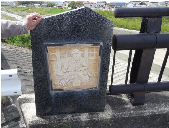
06.楮の皮剥ぎ作業が親柱に
