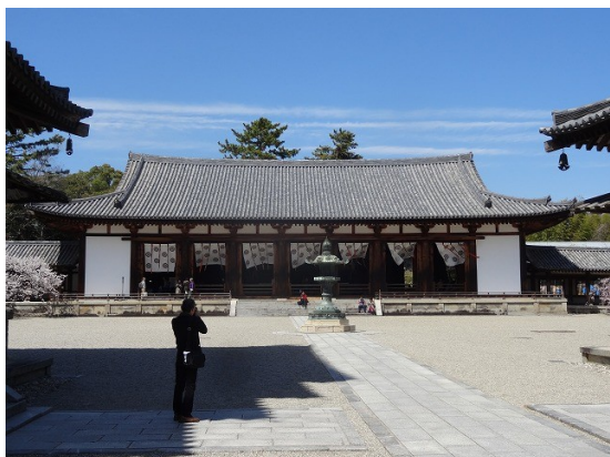
26.大講堂は吹き抜けて風が通り抜ける
