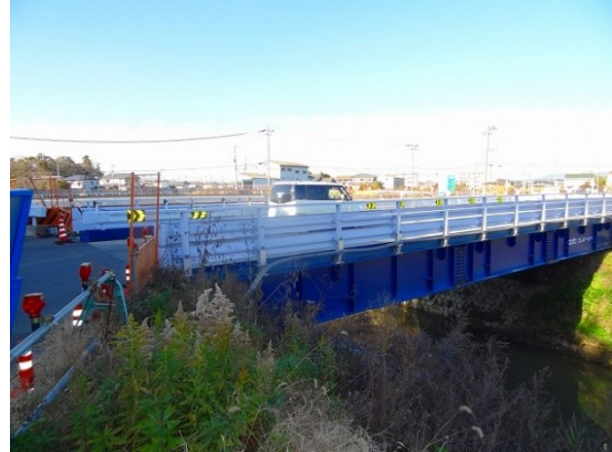
23.完成間近の「庚申橋」の隣には立派な仮設橋が
