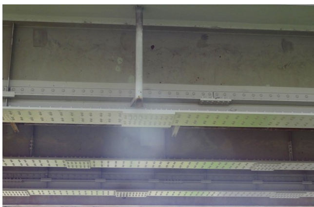
11.珍しい水平スチフナー（補強材）が入っているぞ
