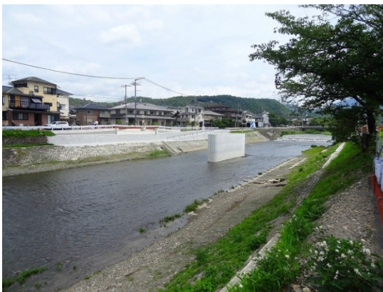
13. 新橋の下部工が完成
