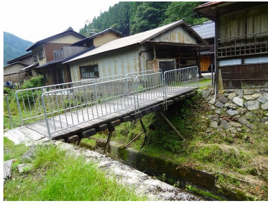
10.桁は鉄だが方杖と床は木を組み合わせた橋
