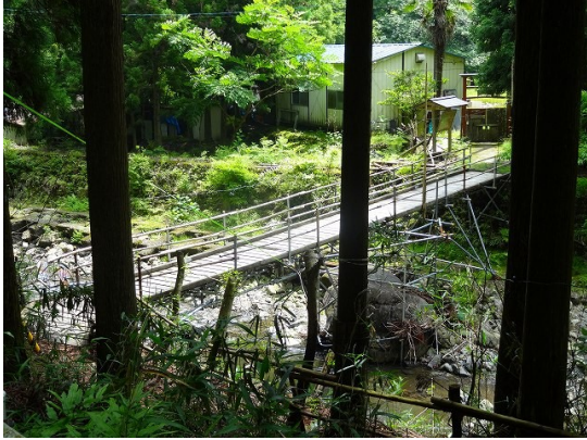
14.これぞまさしく仮設橋だ
