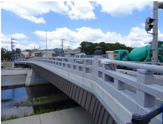
11.「御蔭橋」の新橋の南半分が完成 て
