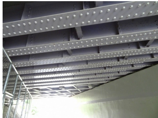
03.両端の歩道部と中央の車道部の桁はけた違いだ
