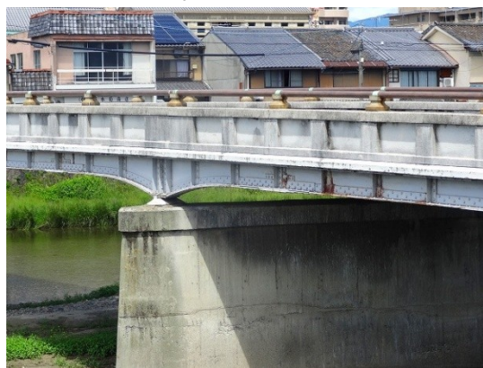
16.正面橋は今は連続桁だが元はゲルバー桁だ
