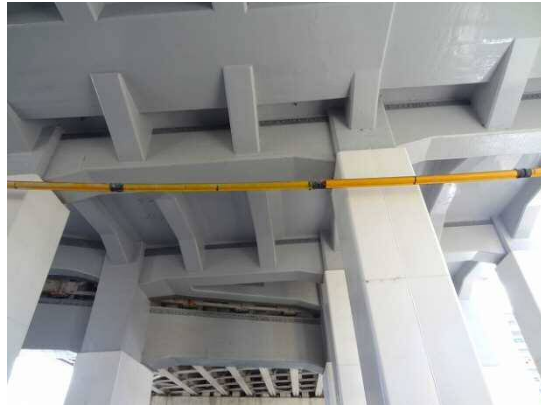
03.府道 143 号（九条通り）の橋は補修済み
