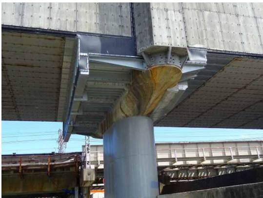
11.上部も下部も防音、耐震対策で鉄 仮面に
