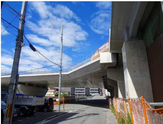
04.古い九条通りの橋に高架橋を接続 させるらしい
