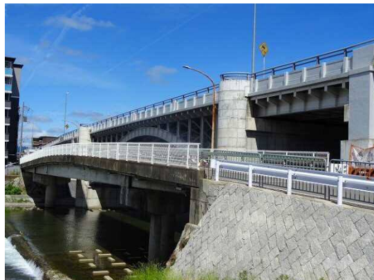
06.手前の市道橋の横が九条通のアーチ橋
