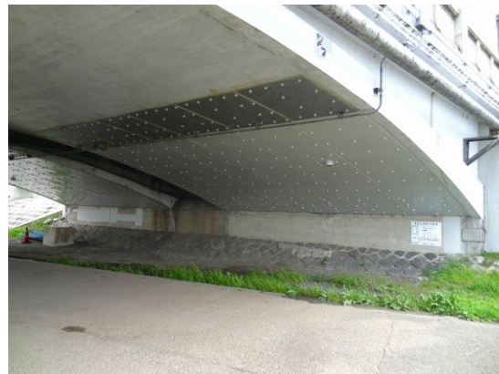
06. コンクリートアーチの底には防護鉄板が
