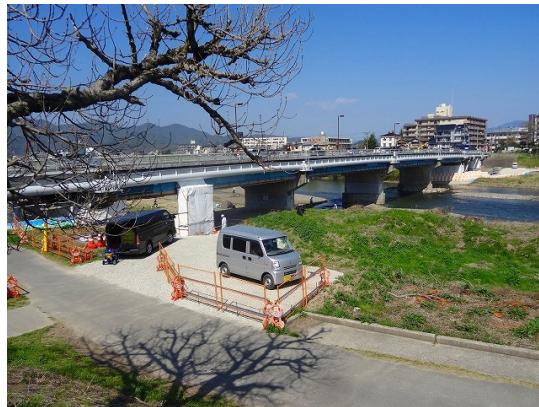
19.府道 186 号松尾橋は耐震補強と桁の補修工事中
