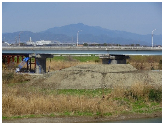
11.耐震補強工事中の「宮前橋」の彼方に「愛宕山（H=924m）」が見える
