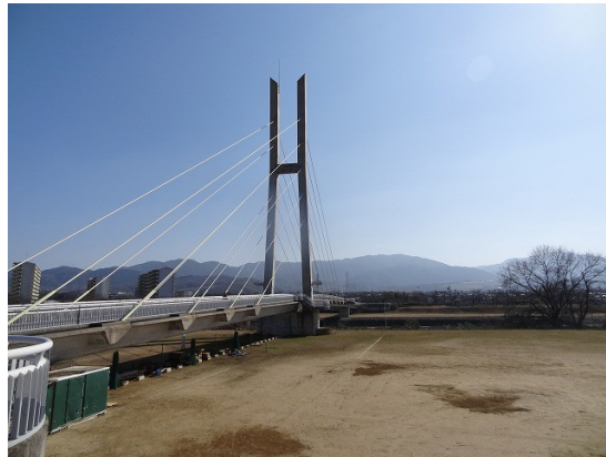
08. 「石川サイクル橋」はハープ形式のPC斜張橋
