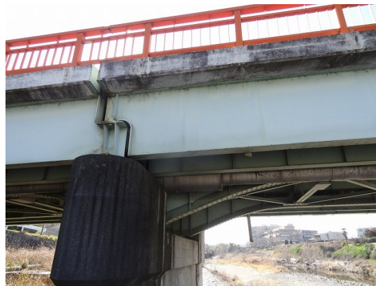
26.「高橋」も支承を減らすため桁の上に桁を乗せているぞ
