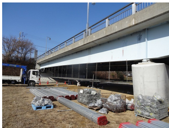
05. 塗装塗り替えのための足場を組み始めた
