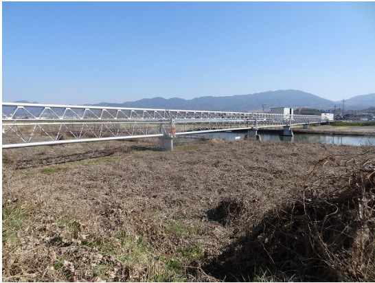
24.「石川水管橋」は2階建て構造だ
