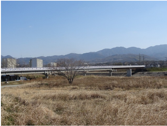
09. PC 橋の「新北橋」の右側 2 径間は 鋼橋になっている
