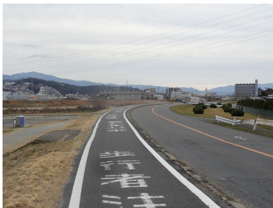
05.石川沿いに整備された自転車道
