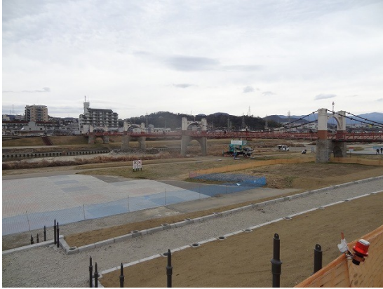
09.多径間吊り橋が現れる
