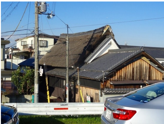
16.土手下に古い民家が残っている
