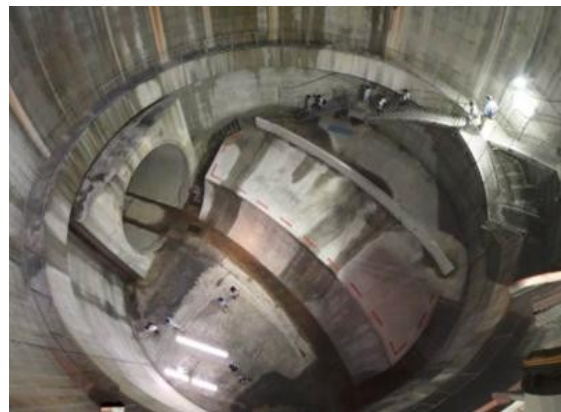
11.寝屋川地下河川若江立坑写真 (大阪府資料から)
