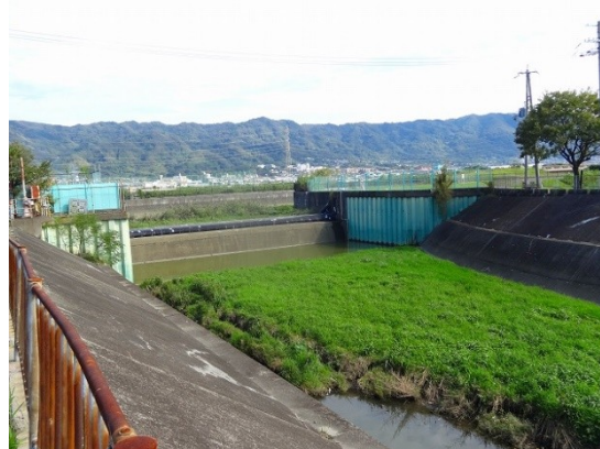
21.恩智川が増水した時に正面の堰から水が溢れ第二寝屋川に入る
