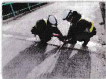
▲橋の上での点検
