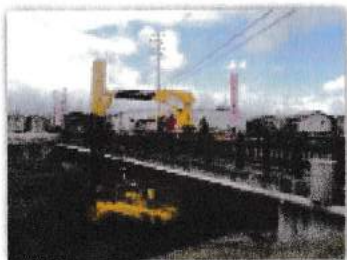
▲橋梁点検車での点検
