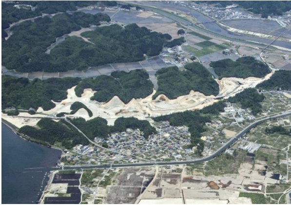
JR 仙石線の野蒜地区の新ルート。 左が松島湾、手前は東名運河、右上 は吉田川と鳴瀬川
