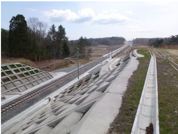
ルートを山側に移し、単線で新設した 宮城県坂元町付近の常磐線。新駅舎も 建設された。17年春開通見込み 左写真は 16.4 塩入。
