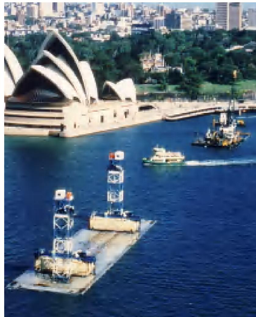
沈埋函の沈設
