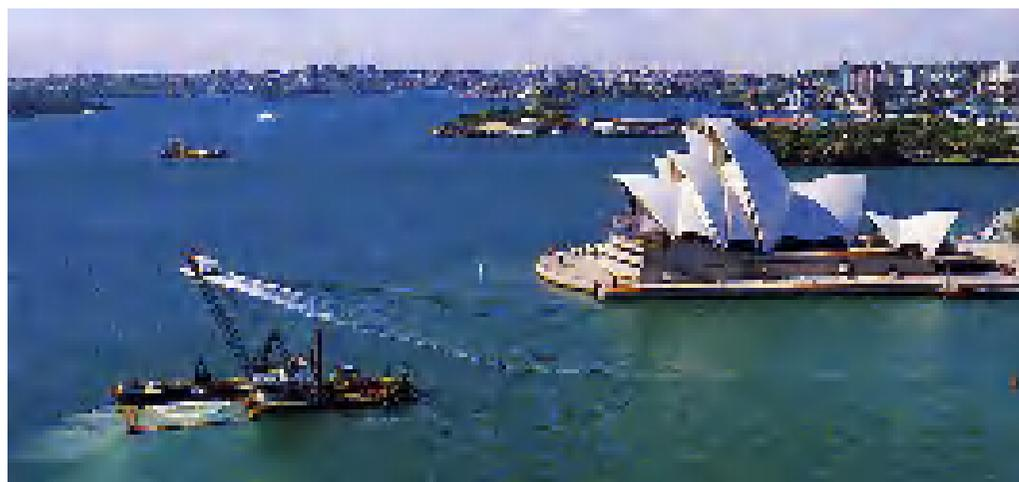
沈埋函沈設箇所の浚渫
