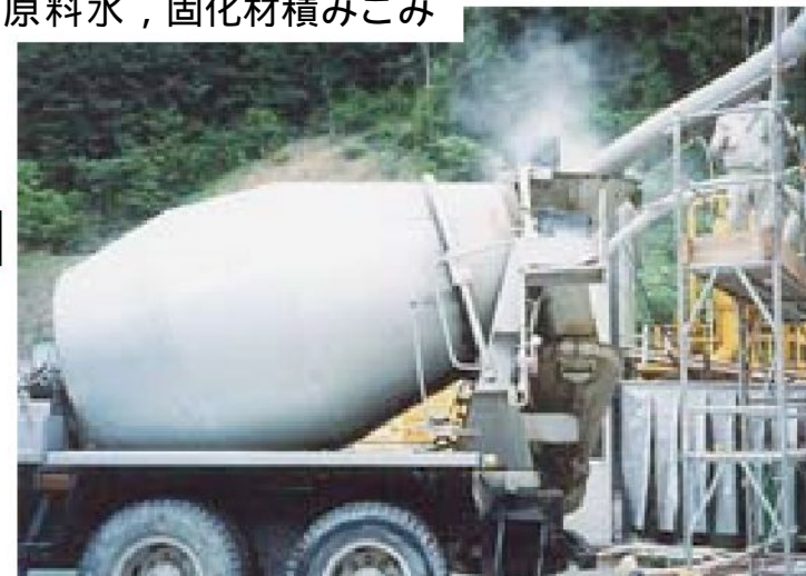
原料水，固化材積みこみ
