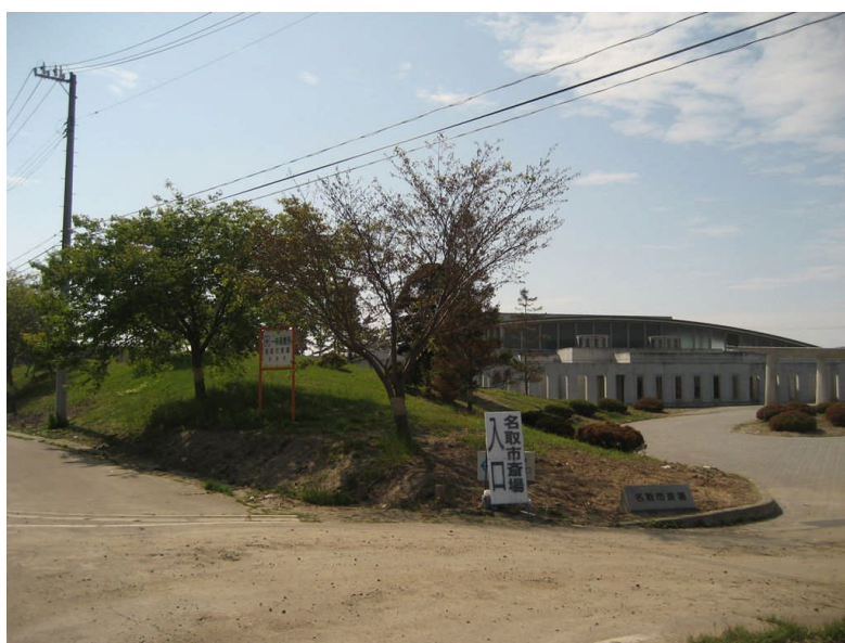
写真一② 名取市斎場入口人工盛土
